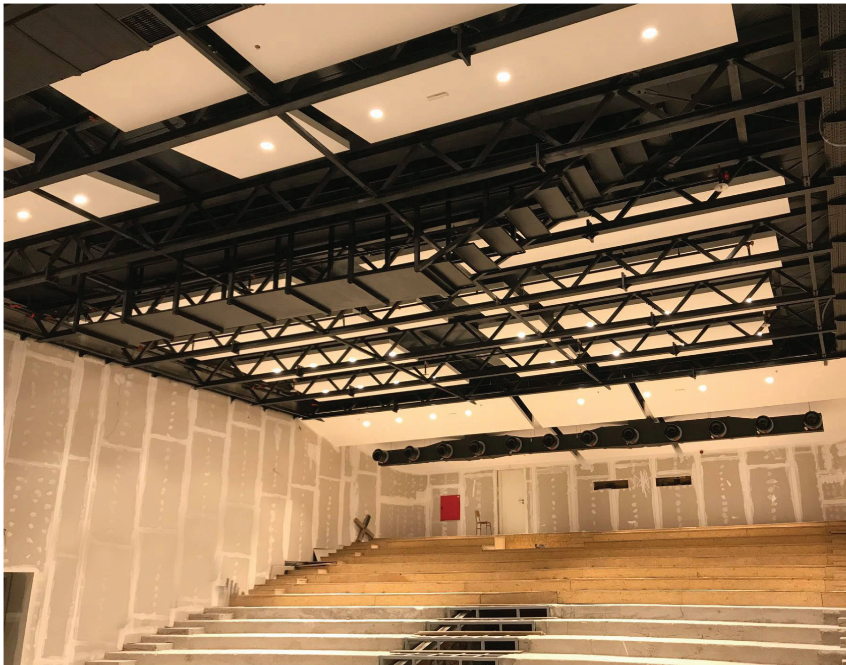
[POSTOJEĆE STANJE] Višenamjenska dvorana, 01.10.2021. godine. Preostali su završni radovi i opremanje.
