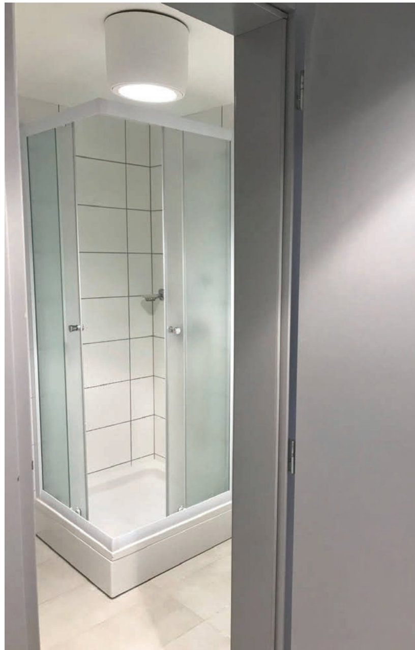
[POSTOJEĆE STANJE] Sanitarni čvorovi, 01.10.2021. godine. Izdana je uporabna dozvola u 2019. godini.
