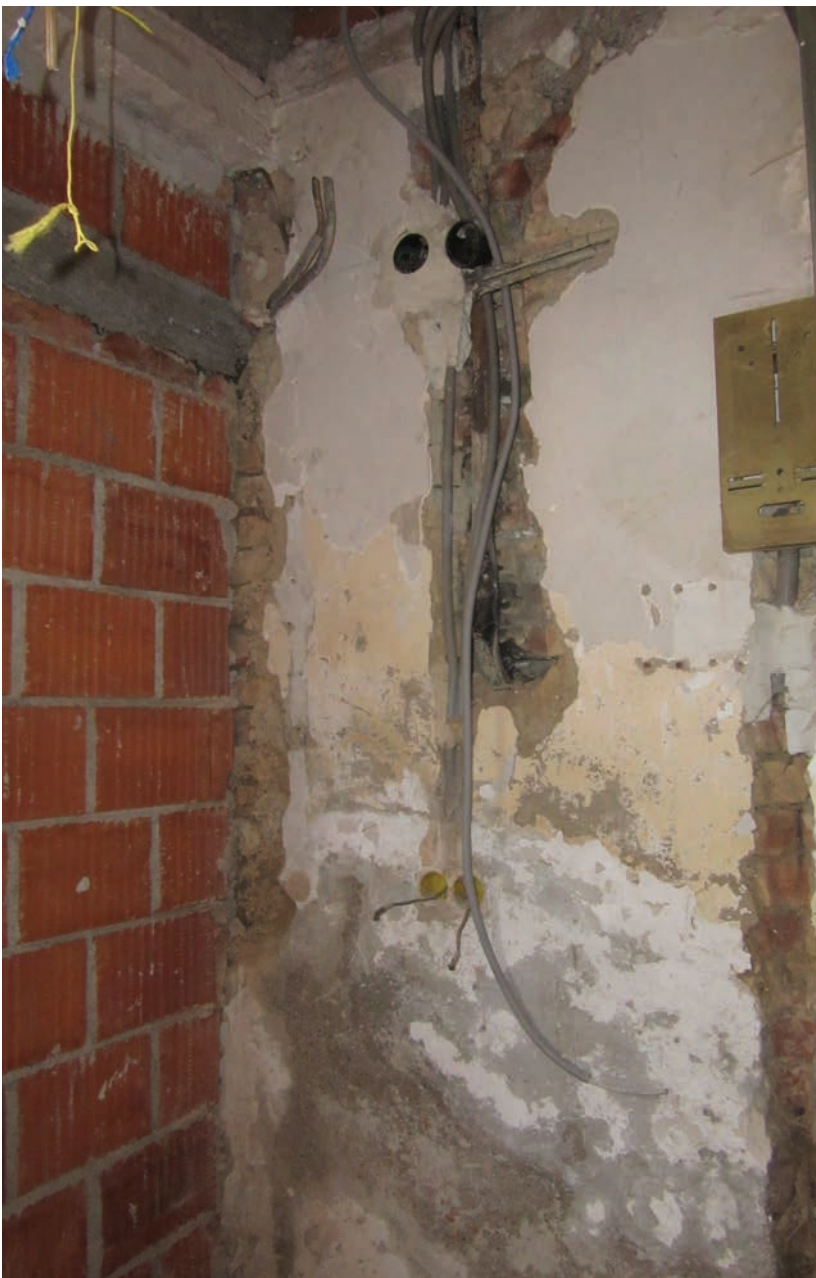
[ZATEČENO STANJE] Sanitarni čvor, 02.01.2018. godine. Fotografiju je izradio ovlaštteni sudski vještak.
